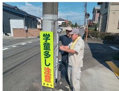
9/11 注意看板の設置
